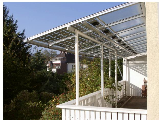
Überdachungen von Carports, Terrassen und Balkonen verbaut mit Solarglas in Glas-Glasausführung, mit Einscheibensicherheitsglas (ESG) oder Verbundsicherheitsglas (VSG).
